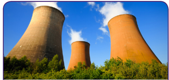
Охлаждающие башни атомной электростанции
