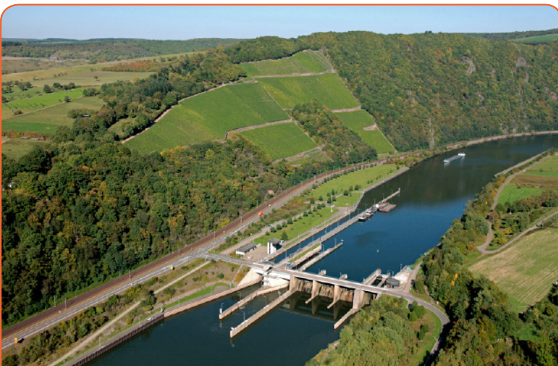
Плотины, расположенные на реках, перекрывают воду, а затем выпускают ее под давлением, пропуская ее через турбины, соединенные с генераторами
